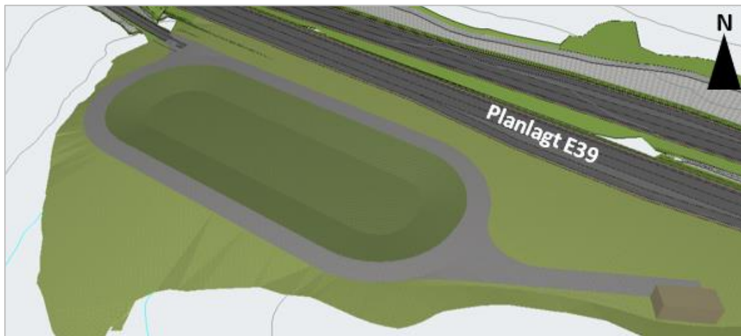
Figur 3-9: Viser sedimentasjonsbasseng med driftsvei i vest, og teknisk tunnelbygg i øst. (Kilde: Sweco Norge)
