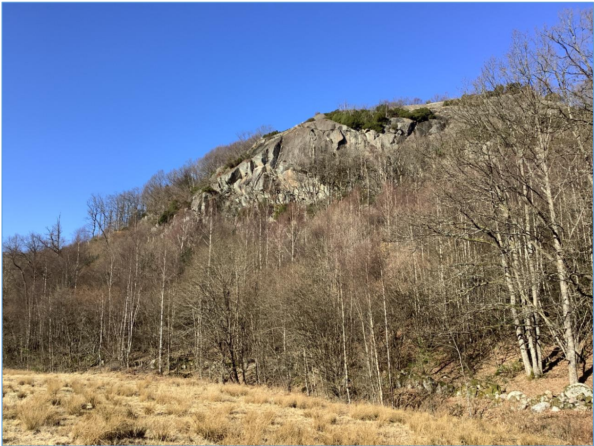
Figur 7: Bergskrenten i overkant av høyre bergskjæring. Bildet er tatt mot nord.
