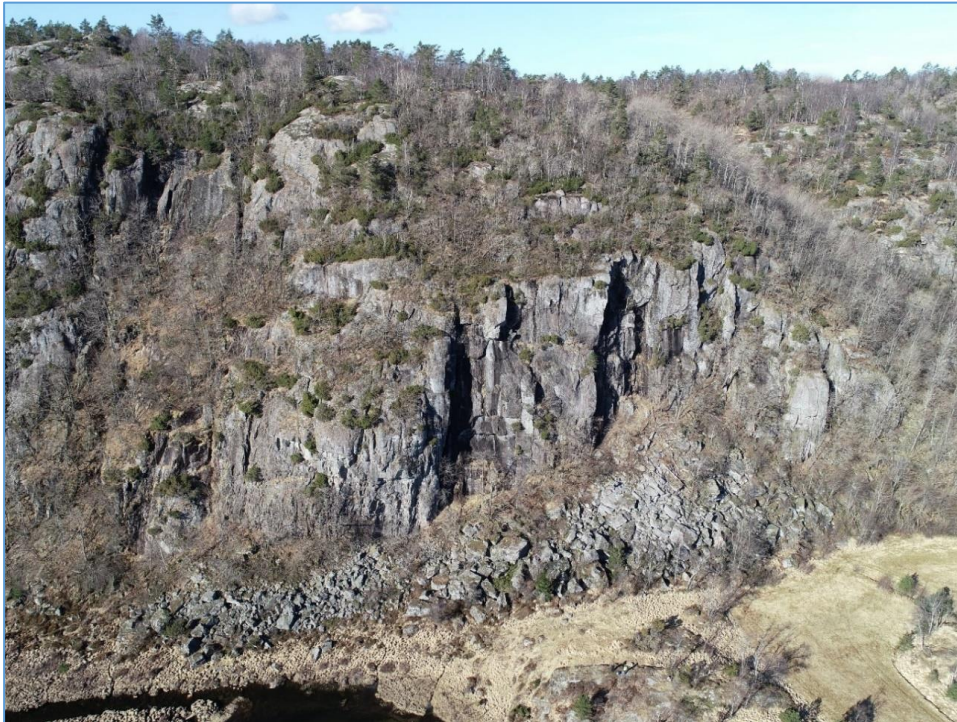
Figur 26: Dronefoto av østlig påhuggsvegg.
