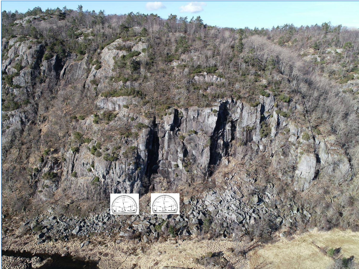
Figur 10: Dronefoto av østlig påhuggsvegg med omtrentlig påhuggsplassering.
