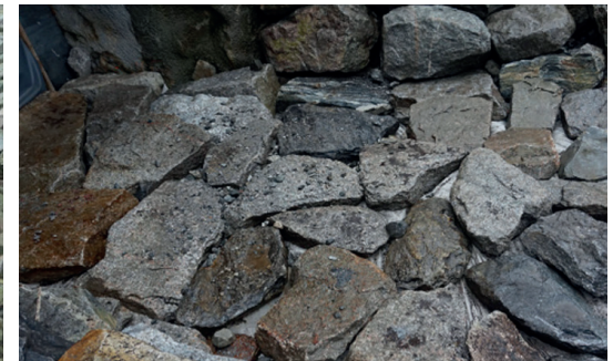
Ordnet plastring til bruk i kryssområder og lignende. Foto: K. Hjelmeland AS
