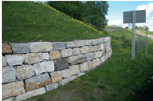
Natursteinsmur ved E16 Bjørum i Bærum. Foto:SVV
