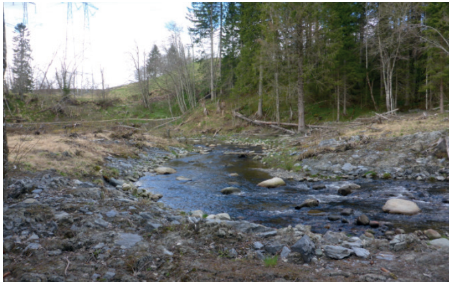
Naturlig utført elveomlegging i nytt, hevet terreng. En inspirasjon til løsningen i Djupedal Foto: A. J. Kjøsnes, NVE
