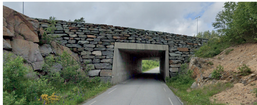
Betongkulvert med vingemur i naturstein, fra lokalvei under E18, Lillesand. Foto: Google
