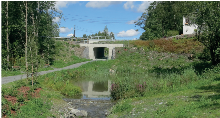
Kulvert med plastøst portal i Skytterdalen. (Foto: Wichada Treepoonpon).
