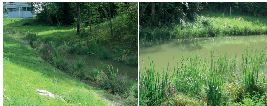
Bekkeåpning langs Skytterdalen etablert med vannvegetasjon slik at det ferdige anlegget ser mest naturlig ut. Foto: Wichada Treepoonpon.
