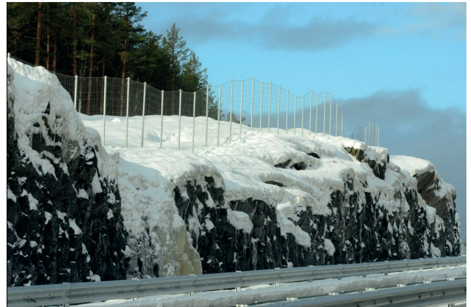
Viltgjerder trukket inn fra skjæringstopp. Foto: Allsikring AS
